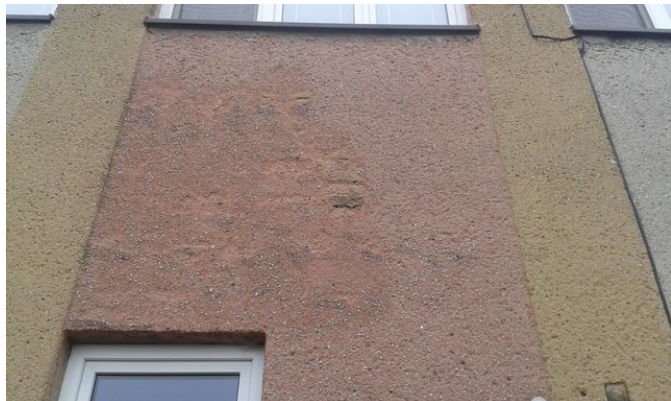
obr. /10/ Degradace fasády – opadávání omítek
