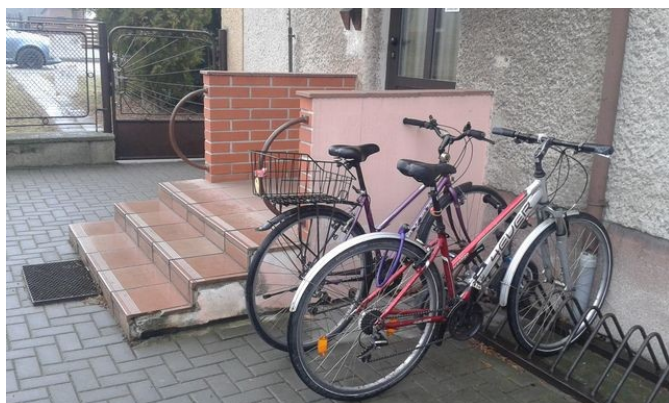
obr. /7/ Na venkovním schodišti dochází k postupné degradaci obkladu schodišťových stupňů z důvodu povětrnostních vlivů a také působením odstříkující srážkové vody
