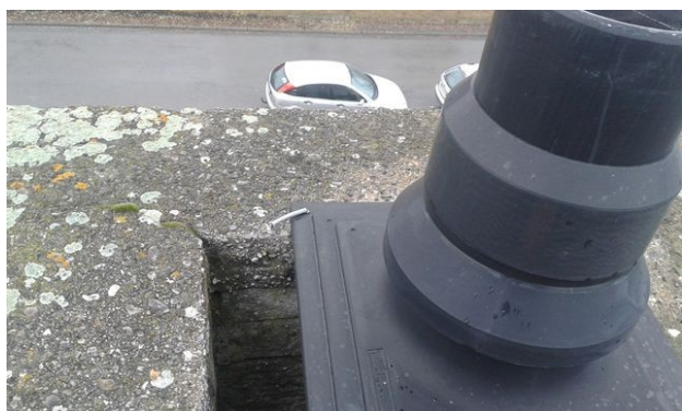
obr. /22/ Nedostatečné zakrytování u komínového tělesa
