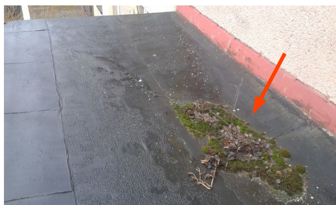
obr. /33/ Plochá střecha se zanesenou a zarostlou vpustí
