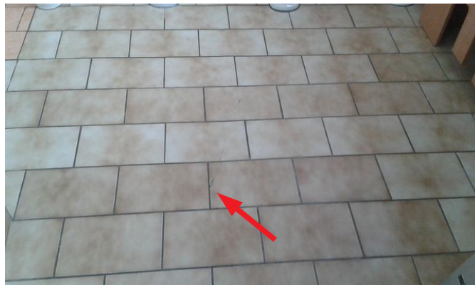
obr. /18/ Lokální výměna dlaždic, které vzhledově neodpovídají těm stávajícím obr. /19/ Uvolněná a popraskaná dlažba na WC
