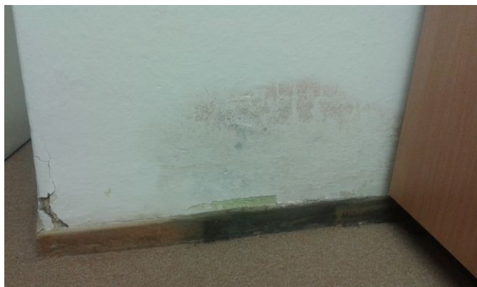
obr. /5/ Vlhkost na vnitřních stěnách projevující se výkvěty na omítce a tvorbou plísní
