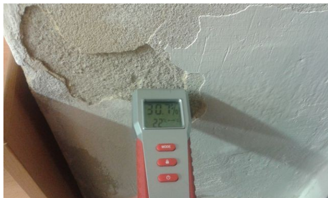
obr. /6/ Na více místech uvnitř objektu odpadává omítka a byla zjištěna vysoká vlhkost zdiva
