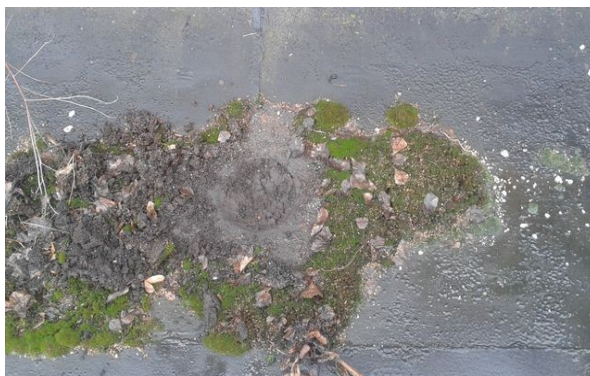
obr. /34/ Zanesená střešní vpust'
