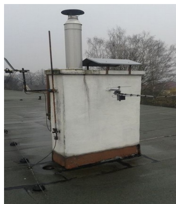
obr. /21/ Absence zastřešení průduchu komínového tělesa
