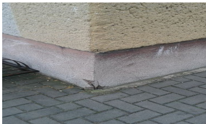
obr. /8/ Rovněž u soklové části dochází ke zvýšené degradaci vlivem namáhání odstříkující srážkové vody
