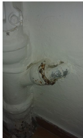
obr. /36/ Místo napojení novějšího připojovacího potrubí od zařizovacích předmětů na původní litinové.
