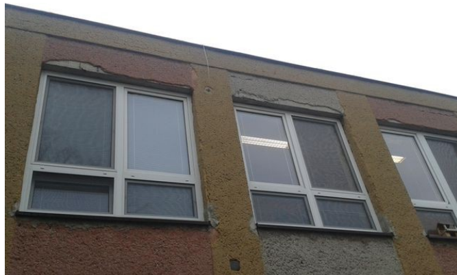
obr. /11/ Odpadávající omítka v místě překladů nad okny
