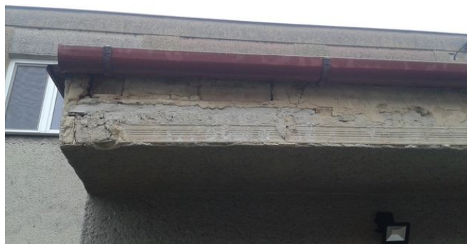
obr. /13/ Odpadávající omítka z čela římsy nad vstupem do objektu
