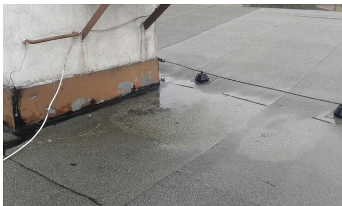
obr. /30/ Z důvodu nedostatečného vyspádování se u komínových těles zdržuje voda
