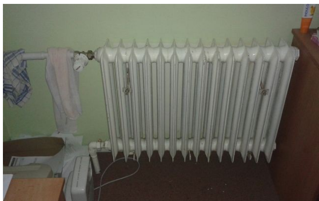
obr. /40/ Původní litinové článkové radiátory
