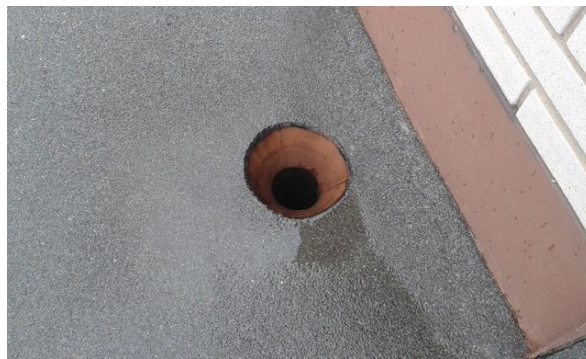
obr. /27/ Chybějící ochranná mřížka u vtoku
