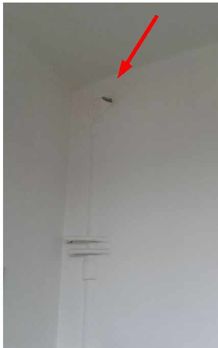
obr. /37/ Pohled na svislé odpadní potrubí s odbočovacím kusem, který není nikam zaústěn ani zaslepen
