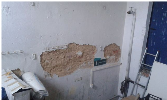
obr. /3/ Opadávající omítka ve sklepních prostorech z důvodu zvýšené vlhkosti stavební konstrukce
