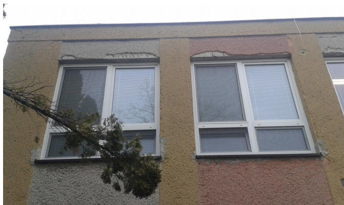
obr. /12/ Odkrytá výztuž překladů nad okny
