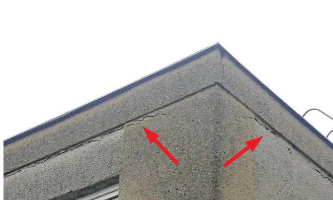
obr. /15/ Trhliny na fasádě v místě atiky
