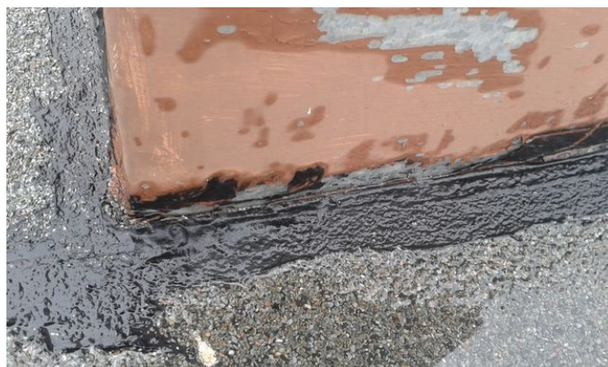
obr. /31/ Absence vytažení povlakové HI na komínové těleso a vznik trhliny ve styku asfaltového pásu a oplechování komínového tělesa
