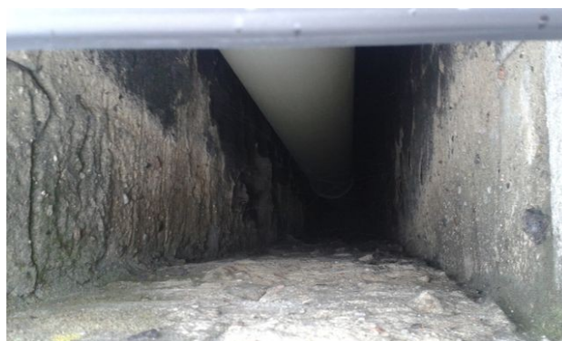
obr. /23/ Degradace vnitřní strany komínů z důvodu špatného zakrytování
