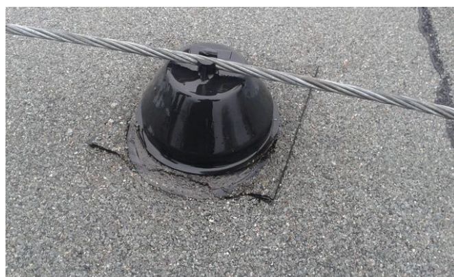
obr. /29/ Zatlačování stabilizační podložky vedení bleskosvodu do povlakové hydroizolace
