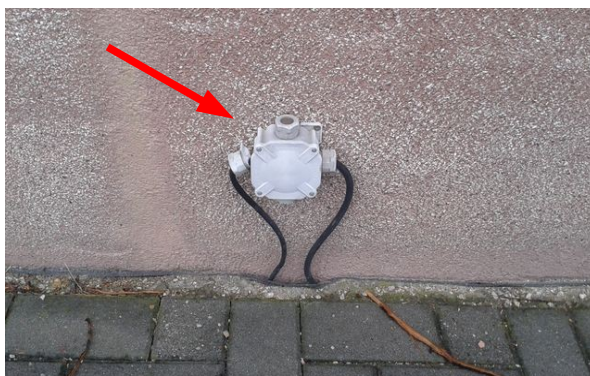
obr. /39/ Vyvedená elektřina na vnější povrch soklu, el. krabice je poškozena, el. kabely nejsou chráněny před poškozením nebo degradací
