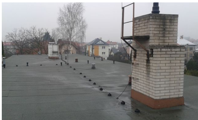
obr. /20/ Stopy stékání srážkové vody po komínovém tělese
