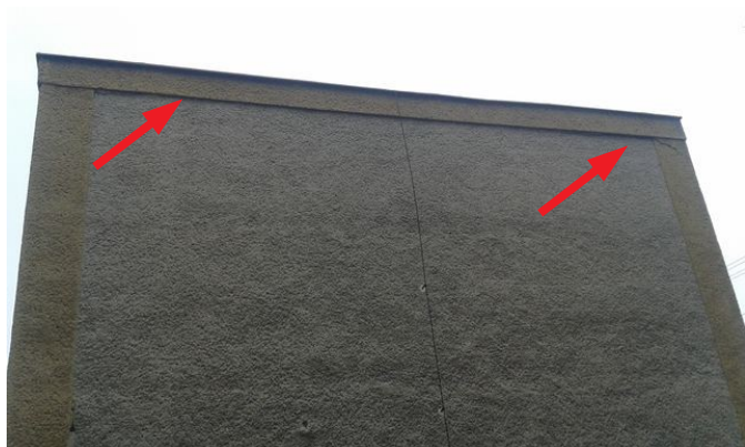
obr. /14/ Trhliny na fasádě v místě atiky
