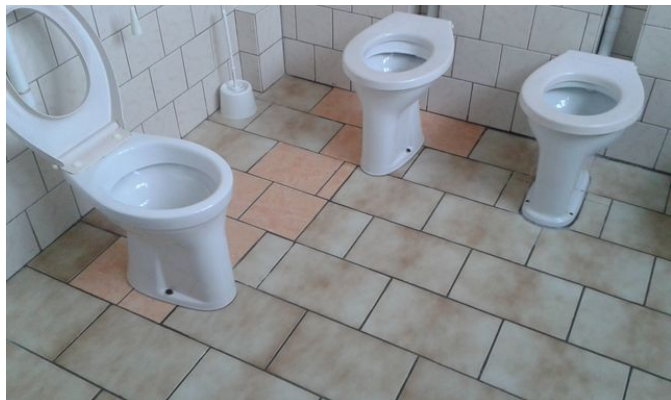
obr. /18/ Lokální výměna dlaždic, které vzhledově neodpovídají těm stávajícím obr. /19/ Uvolněná a popraskaná dlažba na WC
