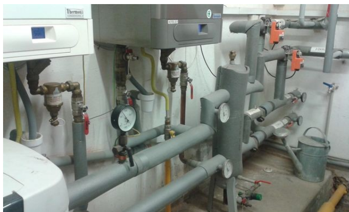
obr. /41/ Soustava kondenzačních kotlů v kotelně
