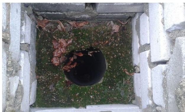
obr. /25/ Nechráněné vyústění komínového tělesa se známkami zvýšené vlhkosti a růstu mechu
