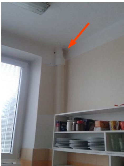
obr. /9/ Vlhkostní projevy a růst plísní v místě prostupu odpadního potrubí střešním pláštěm
